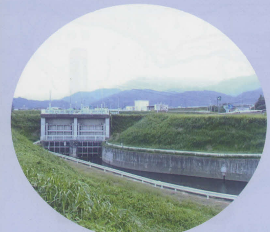
坪川を伏せ越す五明川
