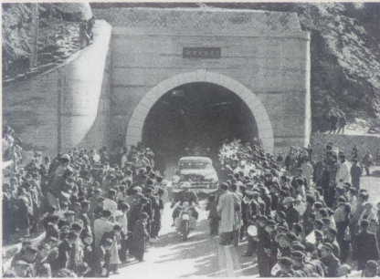
新笹子トンネル開通
