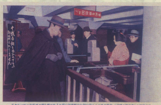
東洋唯一 東京地下鉄道絵葉書 (10銭白銅貨をもちいた日本初の自動改札) 個人蔵
